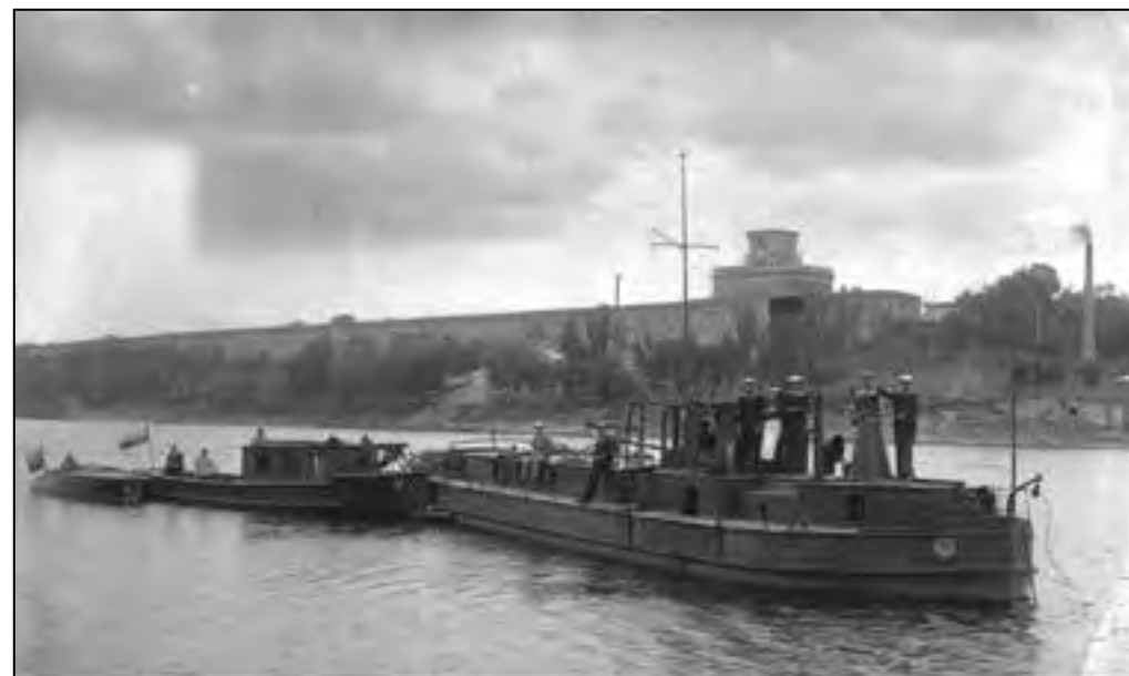
Flotylla rzeczna na Narwi w Modlinie. Widoczne od prawej: statek uzbrojony (holownik tylnokołowy) „Neptun” z armatą 47 mm Hotchkiss wz. 85 i ciężkim karabinem maszynowym Maxim wz. 1908, kuter uzbrojony z ckm Maxim wz. 1908 i motorówka łącznikowa. W tle cytadela Twierdzy Modlin z Wieżą Białą; 1925 r.
