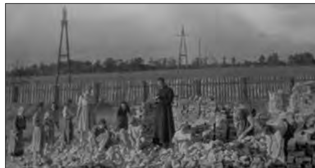
Ks. Józef i dziewczyny na placu budowy
