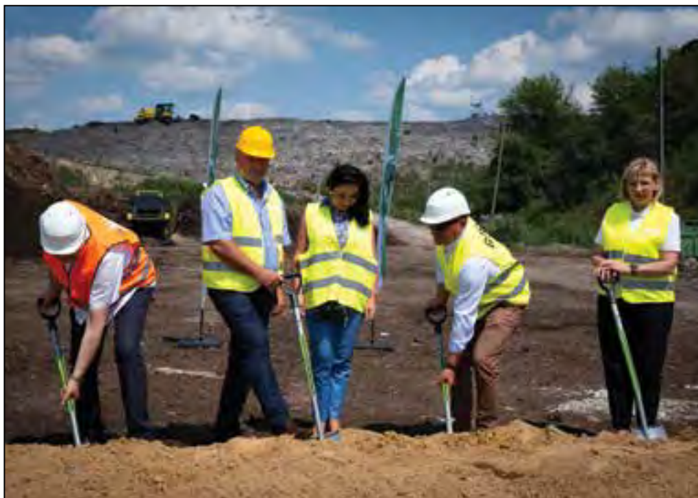
10 lipca. W Starych Lipinach ruszyła modernizacja zakładu MZO Wołomin, dzięki której powstanie Nowoczesne Centrum Recyklingu z hermetyczną kompostownią i sortownią
