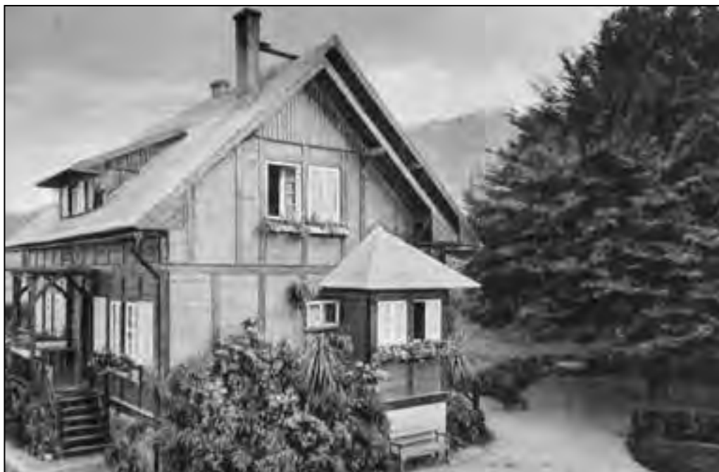
Dom w Sobieszowie przy ul. Szkolnej Nr 6
